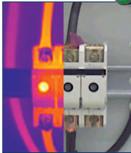
Beispiel eines defekten Bauteils auf einem Wärmekamerabild
